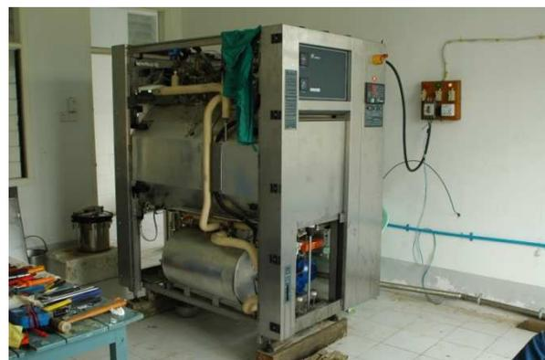
Ce même jour, AUNG KHINE se charge de faire faire la vidange en ville, courbure, soudure, etc.... Nous en assurons la mise en place, la fixation, le percement du mur et le raccordement final. Un raccord direct sur l'eau de l'hôpital est fait en provisoire de même que le raccordement pour l'air comprimé.
