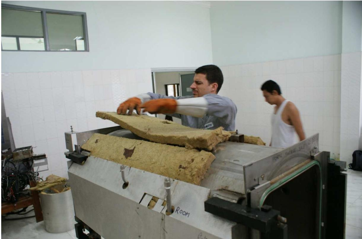
Calorifugeage de la chambre
