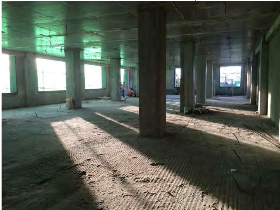
Visite des étages du chantier
