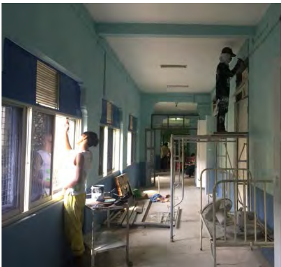
Pendant les travaux
